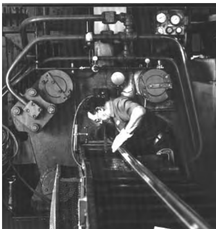
На этой фотографии 1978 года виден алюминиевый лист, выходящий из экструдера. Форма профиля формируется путем продавливания раскаленной болванки через форму.
